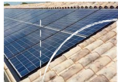
Intégré au bâti
